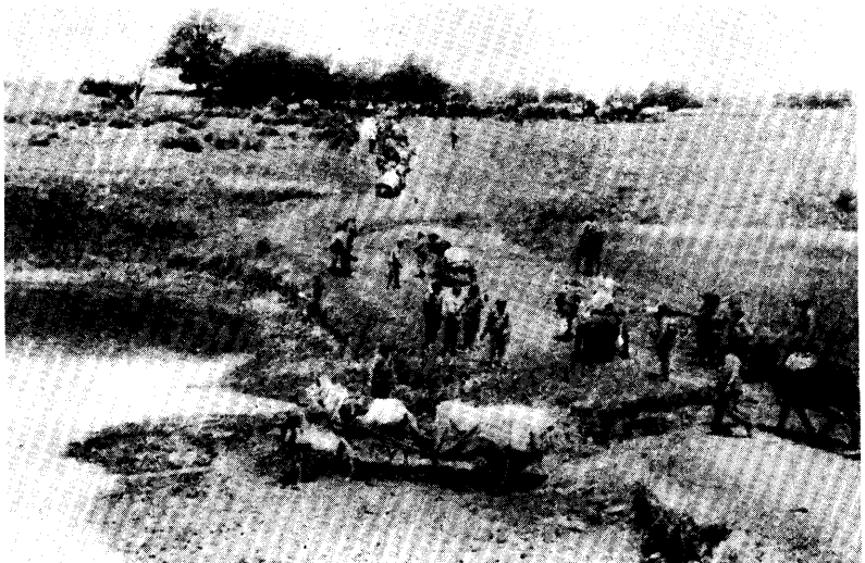
前進路が破壊され修理する工兵隊
